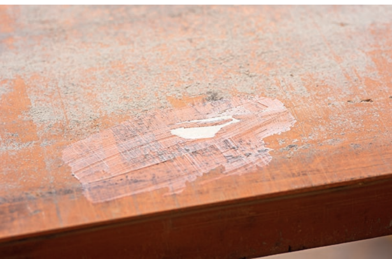
Daño superficial reparado
