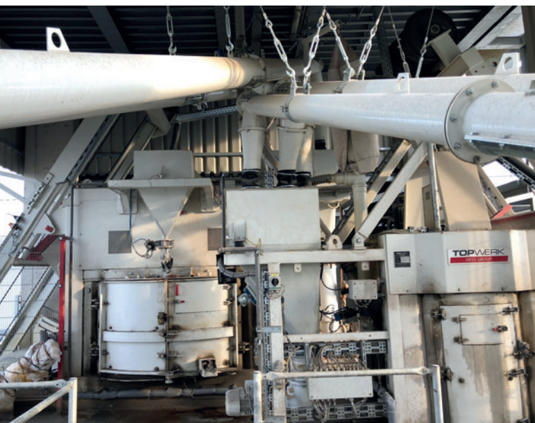
Zur Betonherstellung wurden ein Hess SM 2250 Betonmischer für den Kernbeton und ein Hess SM 400 Betonmischer für den Vorsatzbeton eingebaut.
