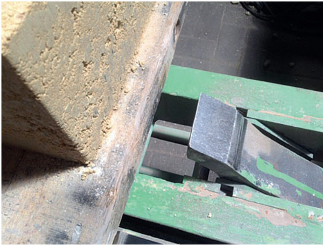
Klinken aus Stahl bilden im Lauf der Zeit häufig eine scharfe Kante an der Oberseite.
