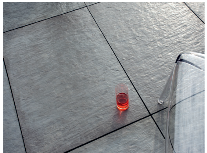
Beispiel für eine weitere europäische Design-Variation von Wasa: Wetcast-Betonsteinplatte als Replikat eines feinkristallinen Glimmerschiefer aus Norwegen
