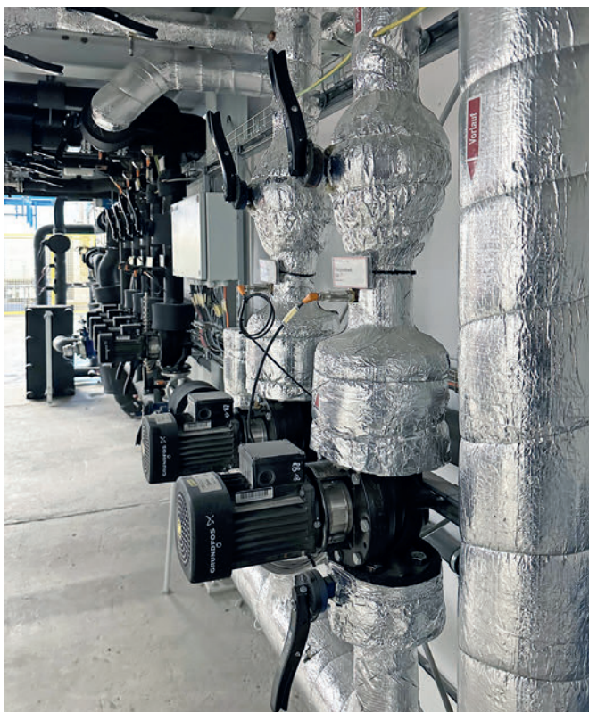
Вода из скважины охлаждает литьевые формы для производства поддона Wasa Uniplast Ultra без ущерба для климата
