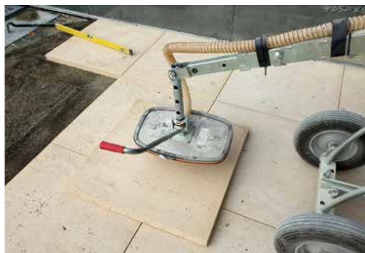
Fig. 7: The large-sized slabs 80 x 80 cm are laid by means of a vacuum lifter Abb. 7: Die Großformatplatten 80x80 cm werden mit einem Saugheber verlegt
