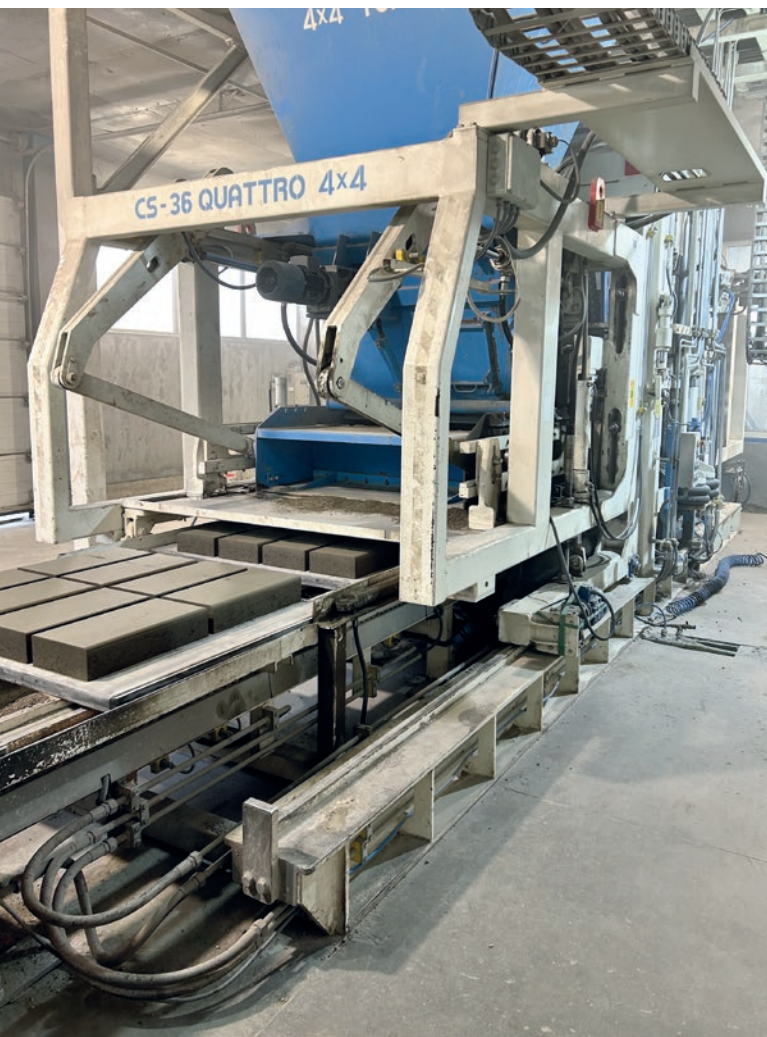
Bestehende Anlage produziert bereits mit Platten von Wasa.
