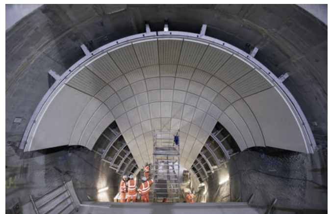
Les panneaux de façade-rideau en béton à fibres de verre sont fabriqués selon le principe de l'arrosage sous pression.
