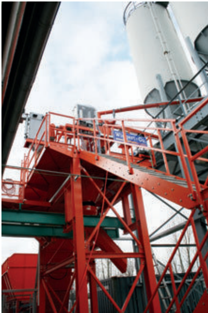
Begehung der Mischerbühne
