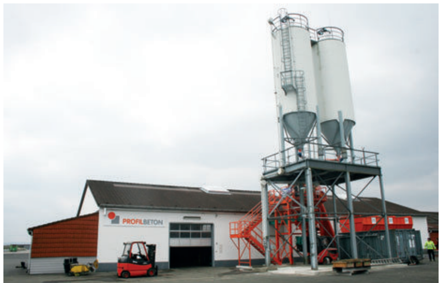
In dieser Halle werden zukünftig bei Profilbeton die Blindenleitplatten im Wetcast-Verfahren produziert. Die Mischanlage von Wiggert wird für den Einsatz in der kalten Jahreszeit noch mit einer Isolierverkleidung eingehaust.
