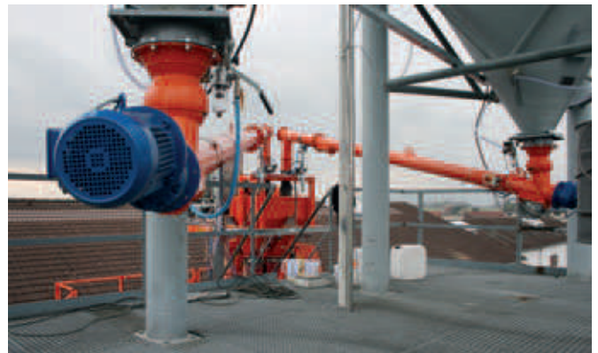
Die vorhandenen Zementsilos wurden von Wiggert mit neuen Förderschnecken versehen.
