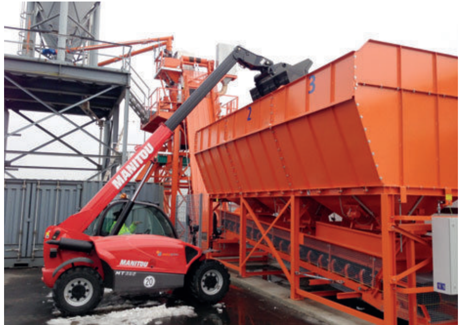
Befüllung der Reihensilos
