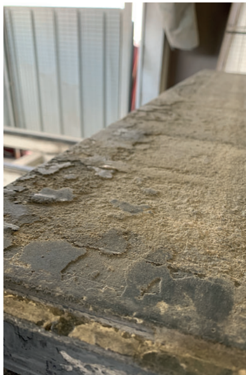
Бетонные налипания
