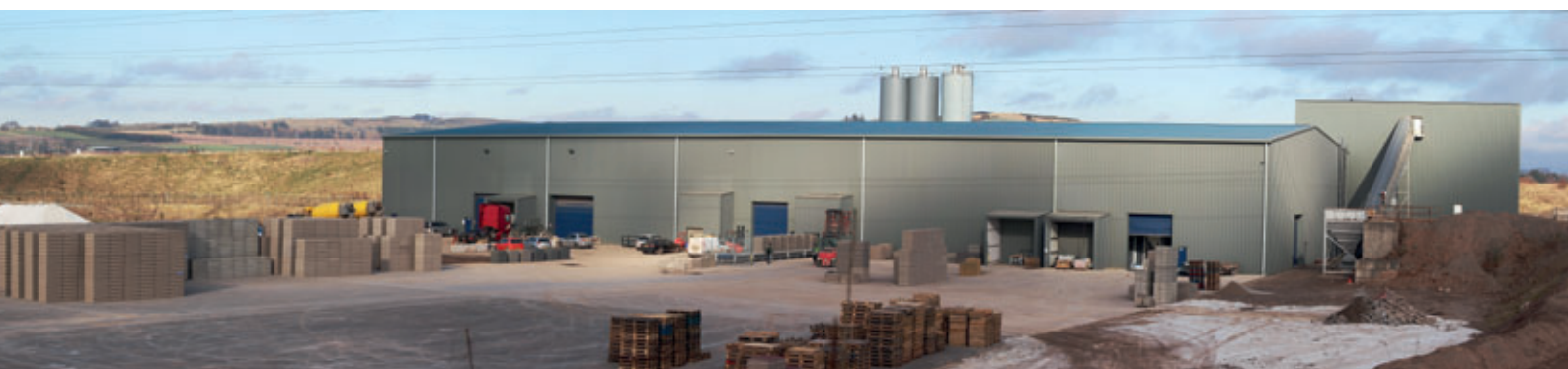
Die neue Produktionshalle bei Laird Brothers mit einem 7 Ha großen Lagerplatz.
