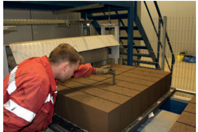
Stichprobenmäßige Qualitätskontrolle vor dem Einlagern in die Aushärtekammer.
