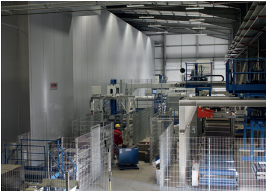
Rekers lieferte auch die Transport- und Handlungsausrüstung der Trockenseite der neuen Anlage.
